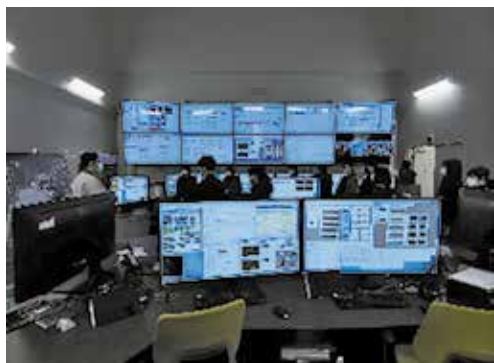
六ヶ所研究所：LIPAc（加速器）遠隔制御室
