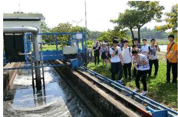
最初の沈殿槽
