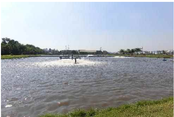
エアレーションによる浄化
